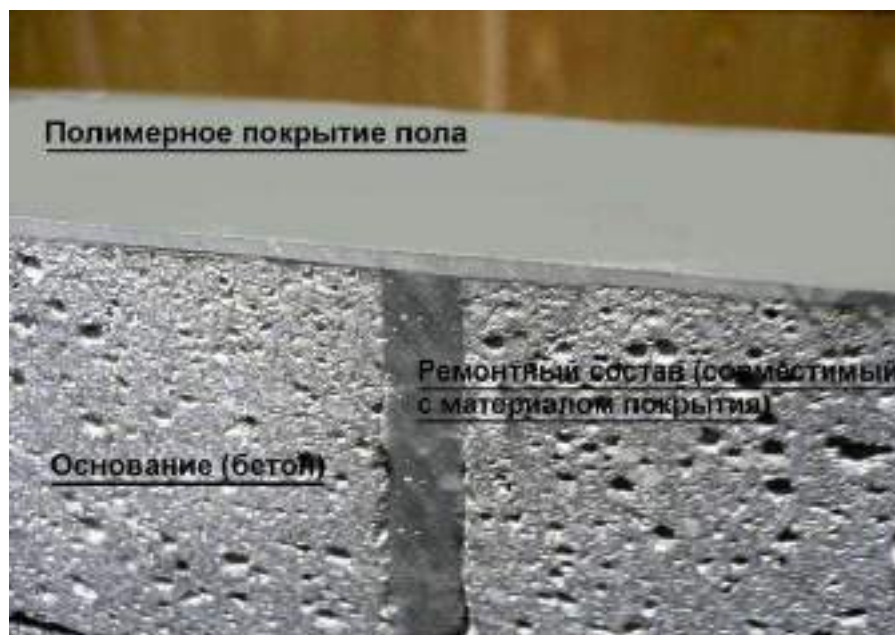
Рисунок 12 - Готовое полимерное покрытие по бетонному основанию с выполнением полимерного анкера из ремонтного состава
