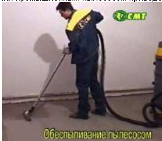
Рисунок 26 – Обеспыливание основания промышленным пылесосом
