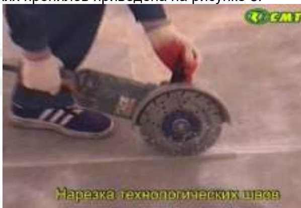
Рисунок 8 - Нарезка технологических пропилов
