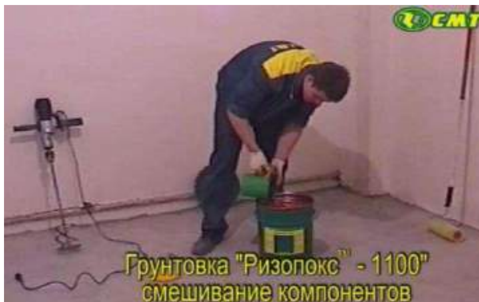
Рисунок 3 - Приготовление грунтовки
