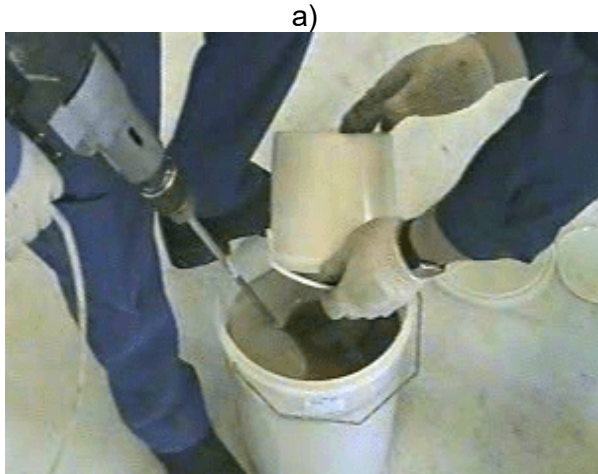
Рисунок 5 - Приготовление составов
