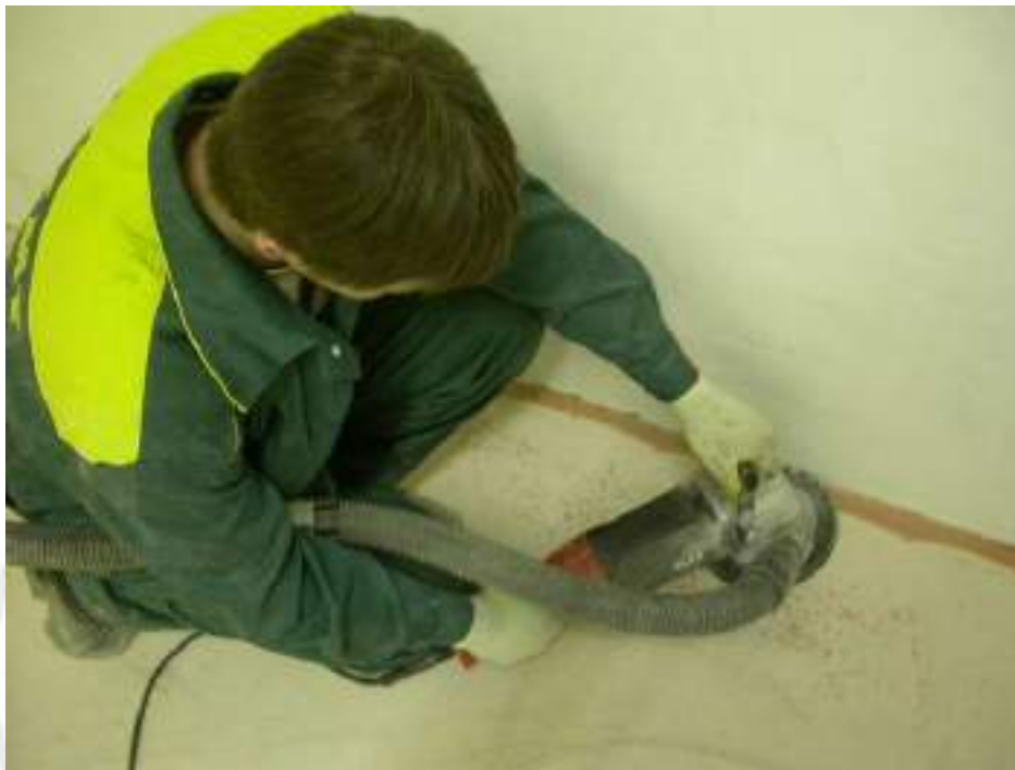
Рисунок 23 - Шлифование поверхности основания шлифмашинкой с алмазной фрезой по бетону
