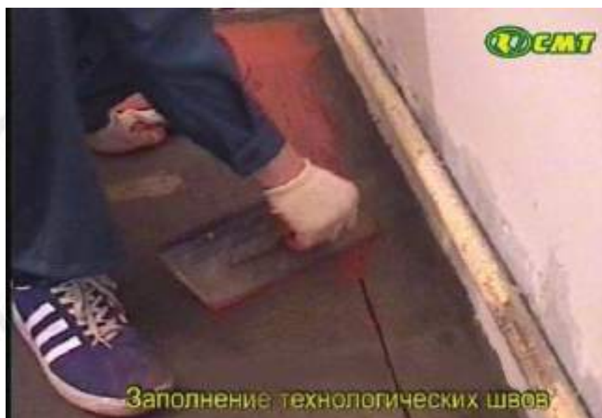
Рисунок 10 - Заполнение (шпатлевание) технологических швов
