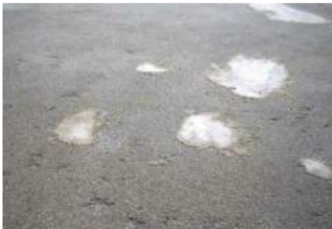
Рисунок 19 - Внешний вид готовых зашпатлеванных участков
