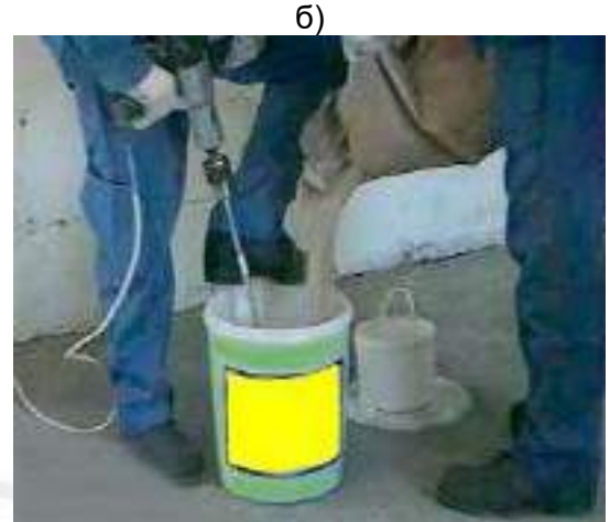
Рисунок 5 - Приготовление составов
