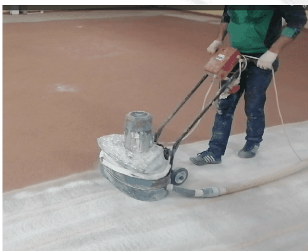
Рисунок 45 - Шлифование поверхности промежуточного слоя из «Ризопокс-4400» или «Ризопокс-3405W База» мозаично-шлифовальной машиной
