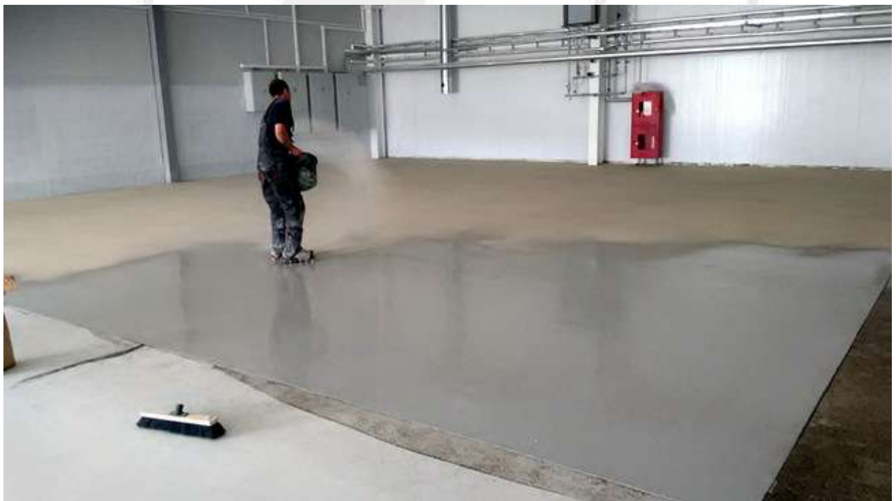
Рисунок 43 - Засыпка поверхности промежуточного слоя из "Ризопокс-4400" или "Ризопокс-3405W База" фракционированным кварцевым песком "под шубу"
