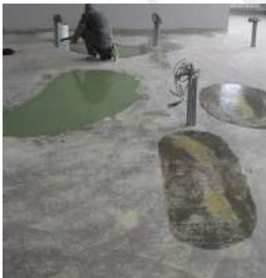
Рисунок 18 – Шпатлевание поверхности основания
