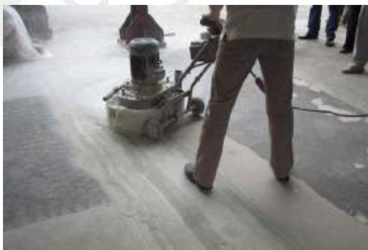
Рисунок 45 - Шлифование поверхности промежуточного слоя из «Ризопокс-4400» или «Ризопокс-3405W База» мозаично-шлифовальной машиной
