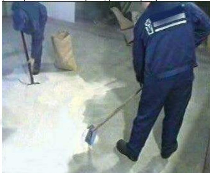
Рисунок 44 - Удаление с поверхности промежуточного слоя лишнего, не прилипшего фракционированного песка
