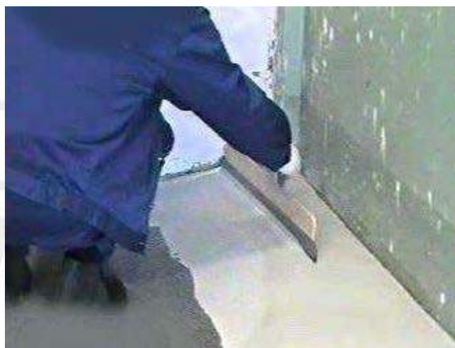
Рисунок 21- Нанесение состава по яме широким шпателем
