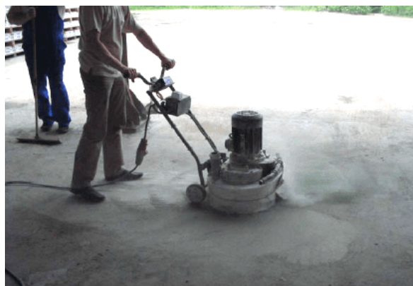
Рисунок 17 - Обработка поверхности мозаично-шлифовальной машиной типа СО 199/310 с алмазными фрезами
