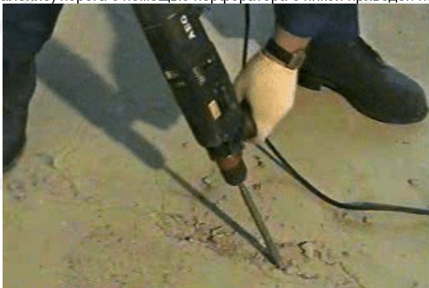
Рисунок 25 - Демонтаж (удаление) порога с помощью перфоратора с пикой
