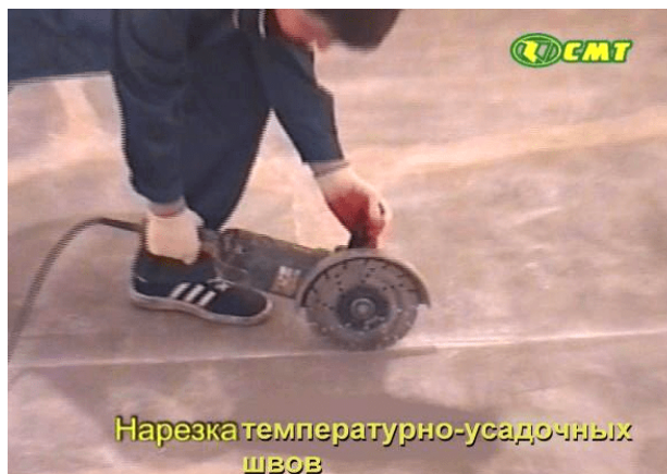
Рисунок 36 - Нарезка температурно-усадочных швов бензорезом или УШМ с алмазным диском
