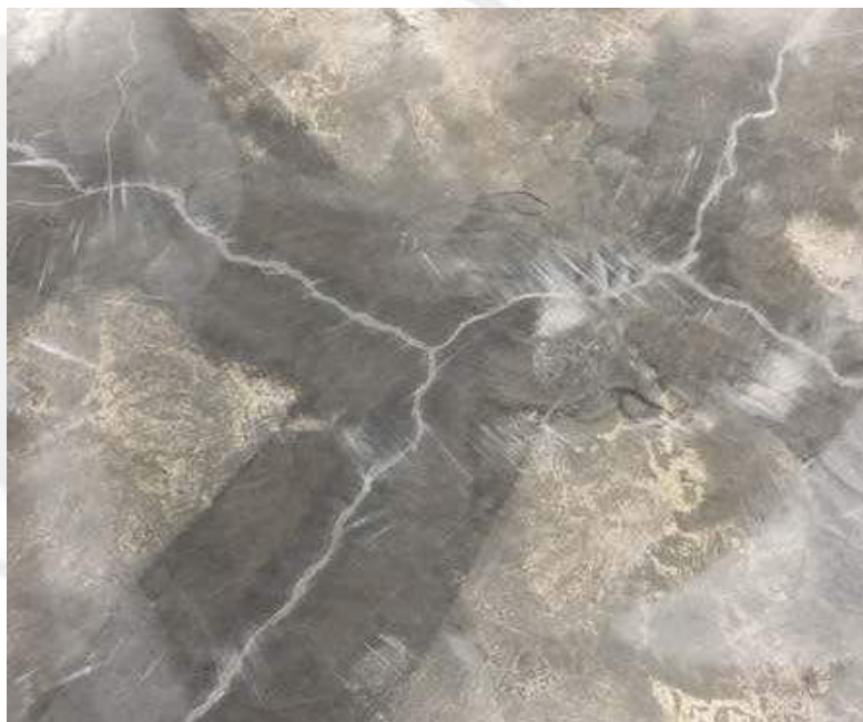
Рисунок 31 - Ремонт трещин (шпатлевка)
