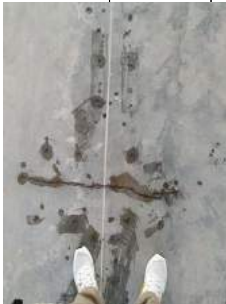
Рисунок 29 – Инъектированная поверхность бетонного основания
