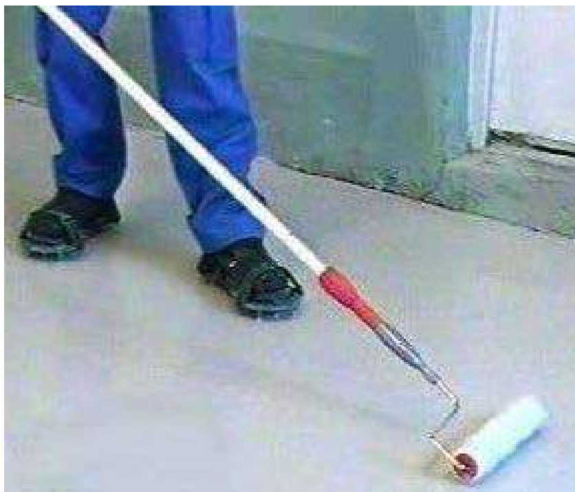
Рисунок 41 - Прокатывание поверхности нанесенного состава «Ризопокс-4400» или «Ризопокс-3405W База» игольчатым валиком для удаления воздуха
