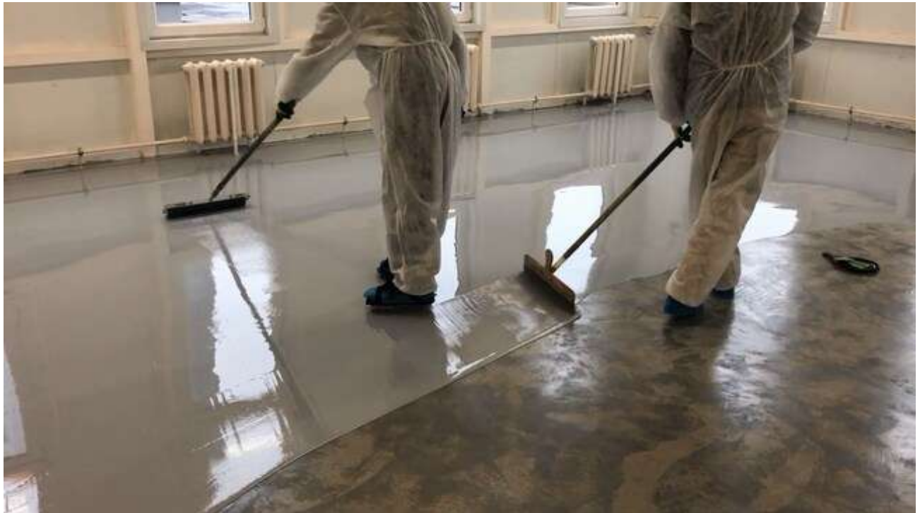
Рисунок 42 - Нанесение промежуточного слоя из составов "Ризопокс-4400" или "Ризопокс – 3405W База" ракелем с зубчатым лезвием методом "под зуб" с последующим прокатыванием игольчатым валиком
