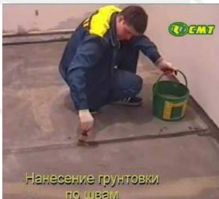
Рисунок 4 - Нанесение грунтовки кистью
