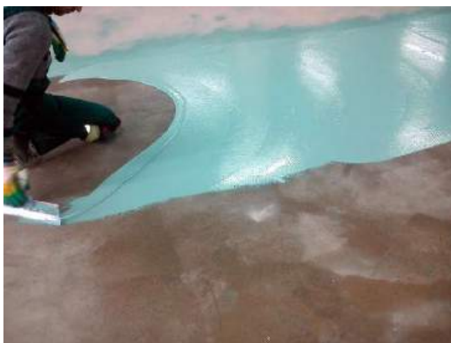
Рисунок 21- Нанесение состава по яме широким шпателем
