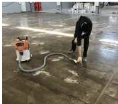
Рисунок 19 - Внешний вид готовых зашпатлеванных участков
