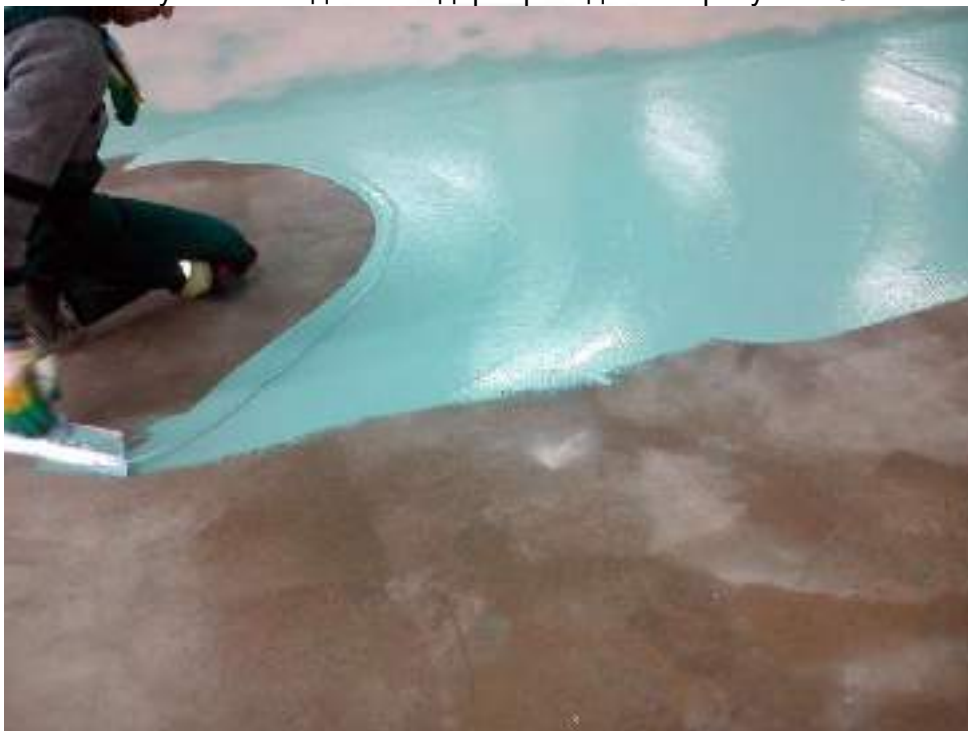
Рисунок 40 - Нанесение промежуточного слоя из "Ризопокс-4400" или "Ризопокс-3405W База" плоским тровелем без зубьев методом "«на сдир»"
