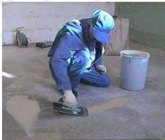
Рисунок 18 – Шпатлевание поверхности основания
