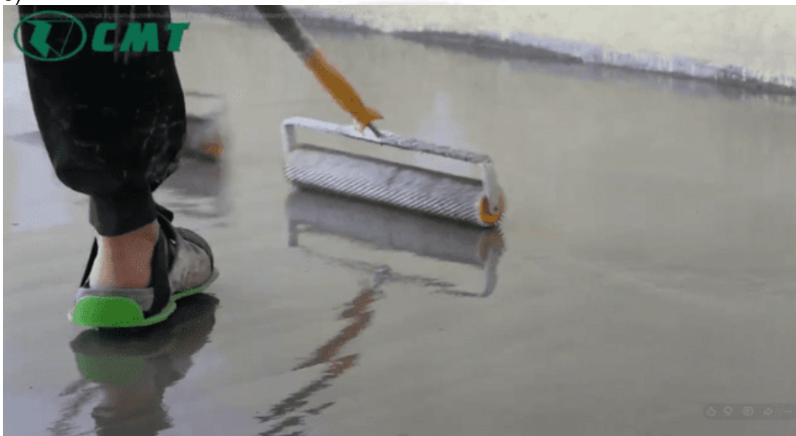
а) распределение растворной смеси "Ризотоп-2220" штырьковым скребком б) прокатывание поверхности деаэрационным (игольчатым) валиком
