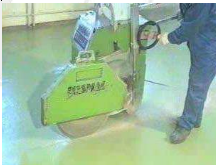
Рисунок 35 – Шпатлевка и последующая нарезка температурно – усадочных швов шов-резчиком с алмазным диском
