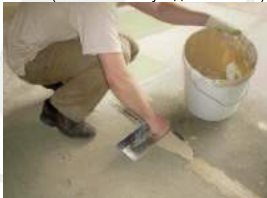
Рисунок 6 – Нанесение ремсостава (шпатлевание усадочного шва)
