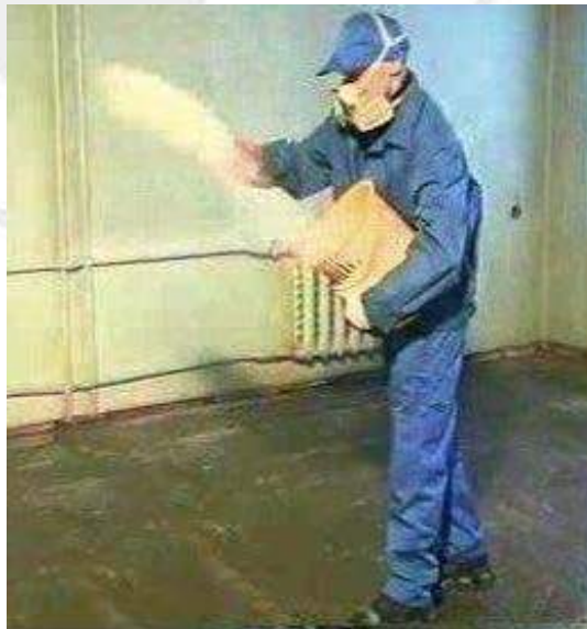
Рисунок 39 - Посыпка поверхности клеевого грунтовочного слоя фракционированным кварцевым песком
