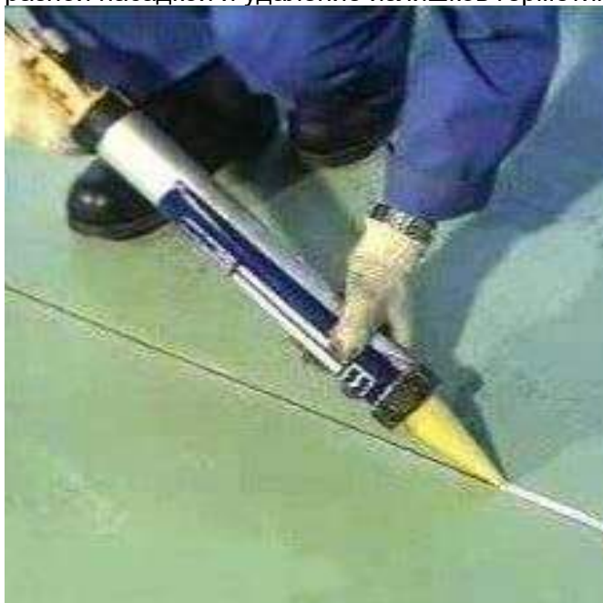
Рисунок 37 - Нанесение полиуретанового герметика в шов пистолетом закрытого типа Сох с конусообразной насадкой
